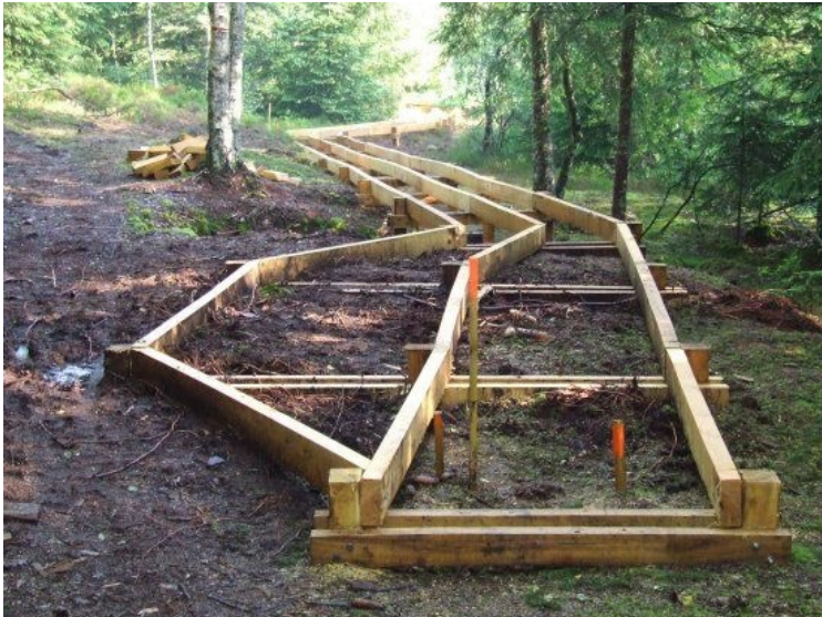
fot. 24 przykładowa konstrukcja ścieżek, torfowisko Frasne, Francja
